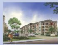
Terra Losa - 198 units
